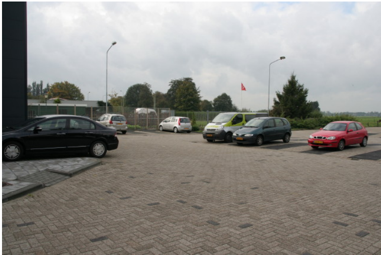
Bestaand parkeerterrein achterzijde
