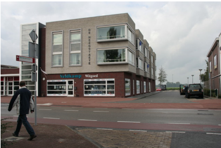
Bestaande in- en uitrit naar achterterrein
