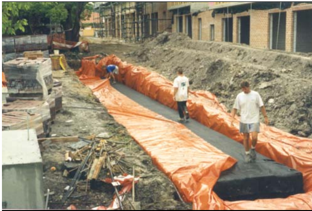
Figuur 1.2 Aanleg ondergrondse retentievoorziening
