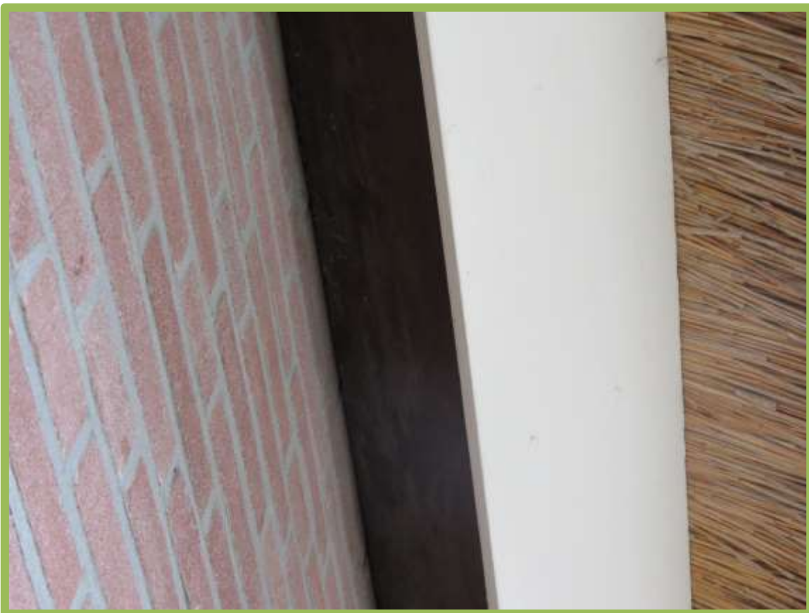
Aansluiting dak / muur kantoor welke niet toegankelijk zijn voor de diverse gebouwbewonende soorten
