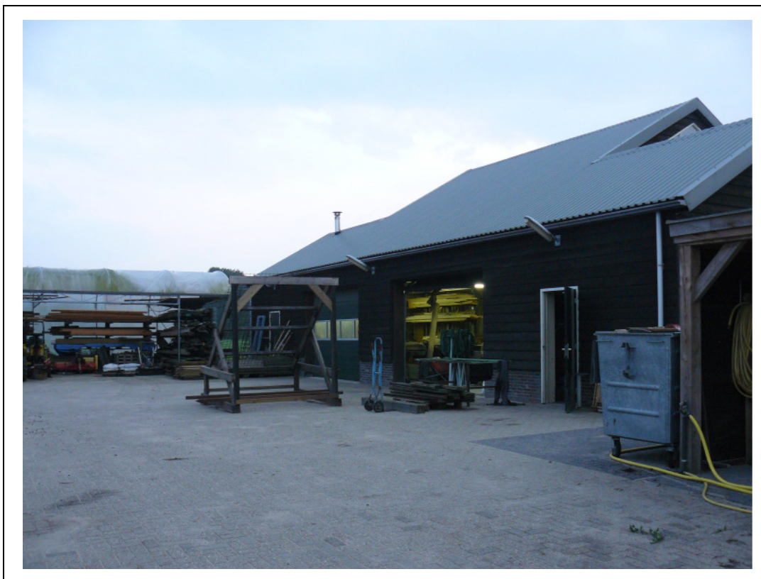
Foto 2. Loods op onderzoekslocatie
