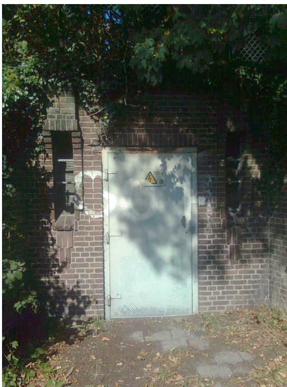
Foto 3. Voormalig elektriciteitshuisje aan de Sophiaweg gelegen in het talud. Het gebouwtje is uitstekend geschikt te maken als (winter)verblijfplaats voor vleermuizen.
