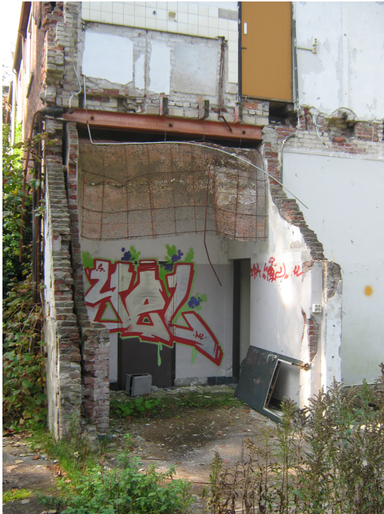
Foto 2. Achter de oranje stalen balk heeft de steenmarter rechtstreeks toegang tot de tussenvloer (opening onder deur).
