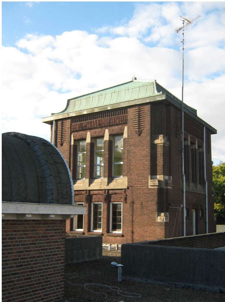
Foto 1. Toren klooster Mariënbosch. In het zuidelijke dak (op de foto het zonbeschenen deel) wordt een opening gemaakt om de zolder toegankelijk te maken voor vleermuizen.
