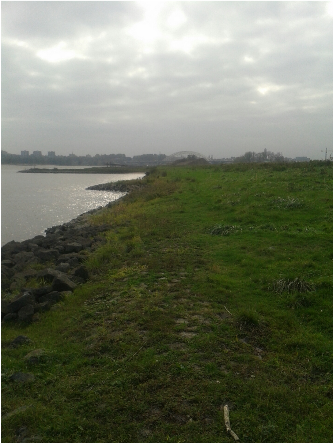
Figuur 4.4: foto van de strekdam in westelijke richting, genomen vanaf de oostzijde van het besluitgebied
