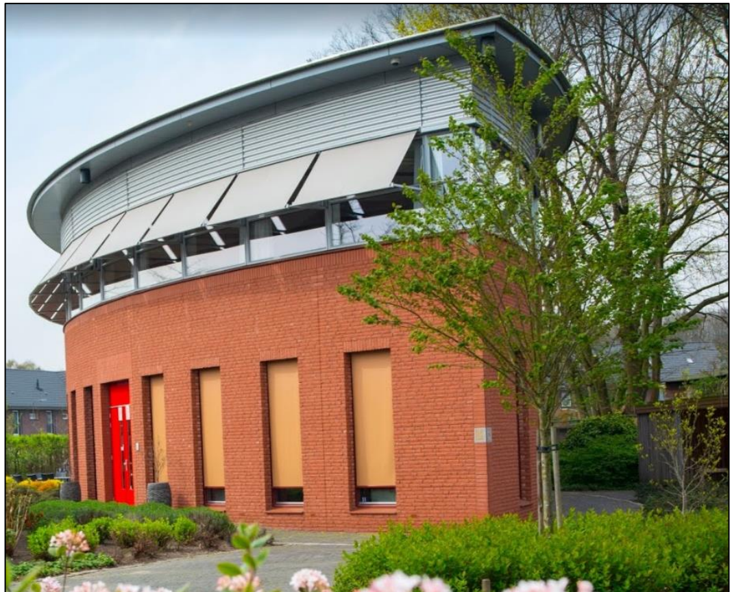
Bestaand kantoorgebouw met karakteristieke uitstraling aan de Godfried Bomansstraat 31
