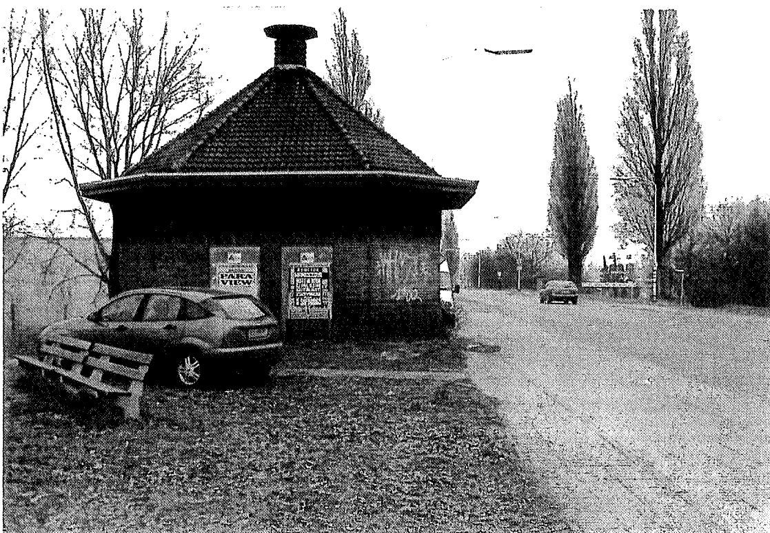
elektriciteitshuisje aan de oostzijde van de locatie
