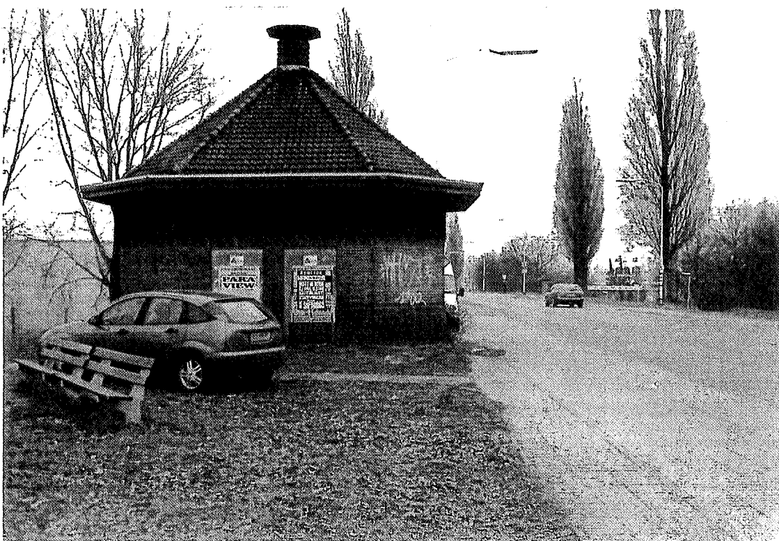
elektriciteitshuisje aan de oostzijde van de locatie
