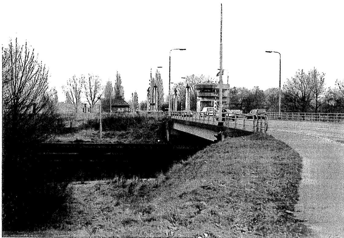
gebied ten noorden van de sluizen en de brug
