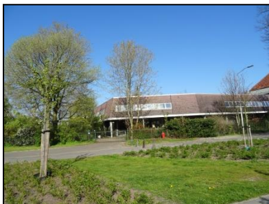
Figuur 3. Te slopen bebouwing ten zuiden van het plangebied.
