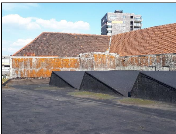
Figuur 18. Het dak van de bebouwing is dicht, mede door gebruik bitumen.
