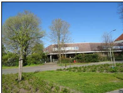
Figuur 3. Te slopen bebouwing zuidzijde van het plangebied.
