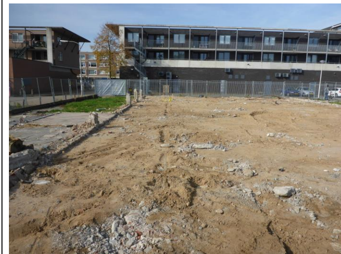
Foto 3: Huidig situatie zuidelijk terreindeel
