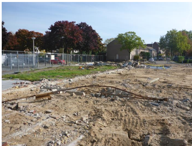
Foto 2: Huidig situatie zuidelijk terreindeel
