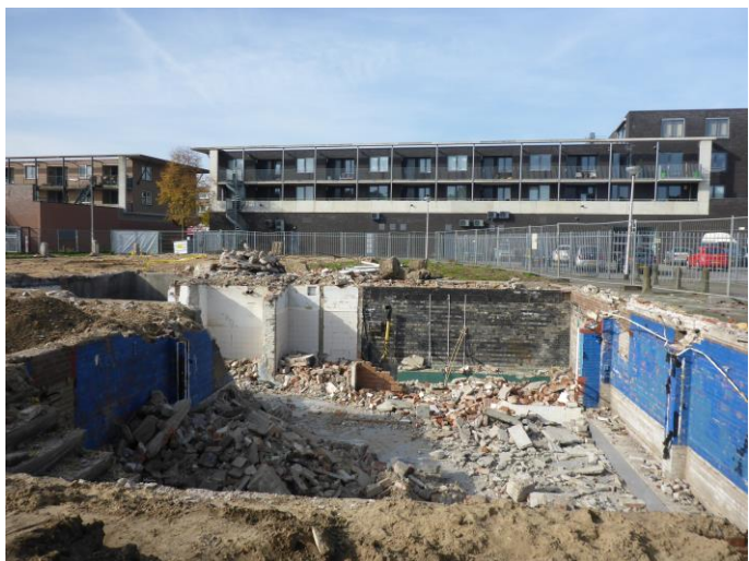
Foto 1: Huidig situatie zuidelijk terreindeel
