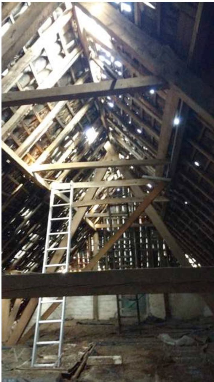
Afbeelding 2: Beeld van de tochtige zolder van de schuur aan de Geulstraat 115.
