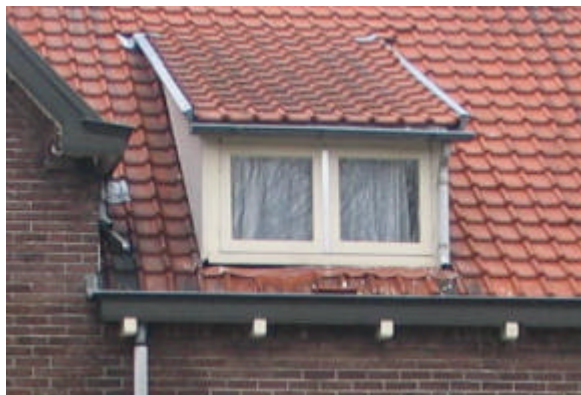
Pastoor Zegersstraat; oorspronkelijke dakkapel
