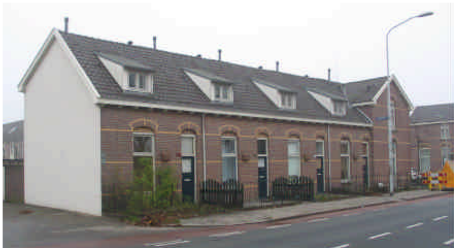
Complex Weurtseweg I- kleine blok (fase II), aan de linkerkzijde vanouds afgesloten met een vlakke eindgevel.
