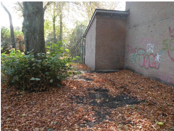
Boom 10, betonplaat tussen boom en gebouw
