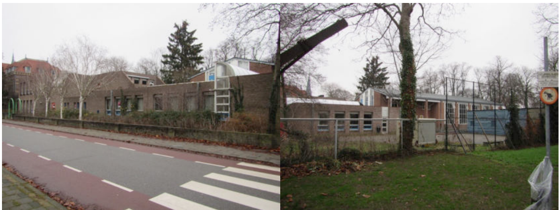
Figuur 3 Straatzijde schoolgebouw en (rechts) zuidzijde met gymzaal.
