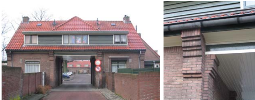
Poortgebouw aan het Beetsplein, boven: voorzijde, linksonder: achterzijde, rechtsonder: detail voorgevel
