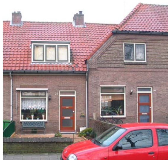
Ramen en deuren hebben bij de renovatie een moderne vormgeving gekregen (hier afgebeeld Beetsplein 29-30)
