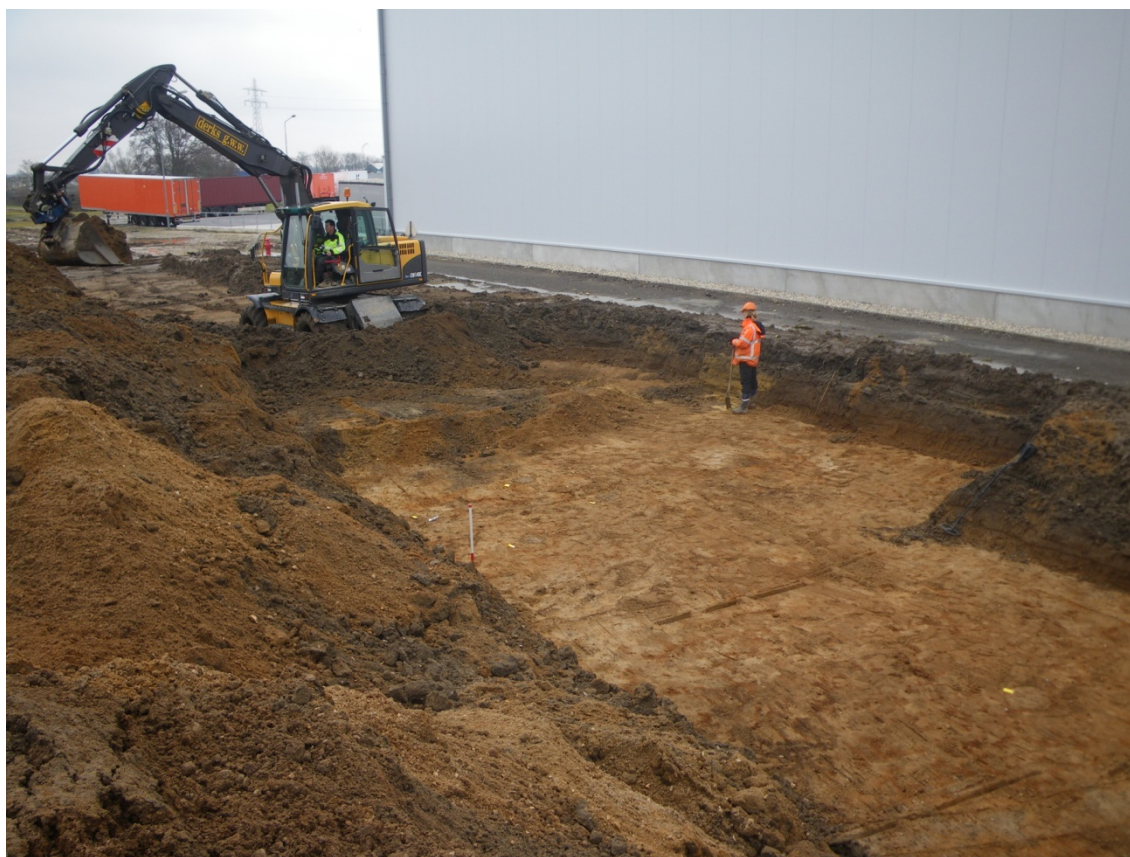
Fig. 4.1: De aanleg van het vlak in werkput 15.
