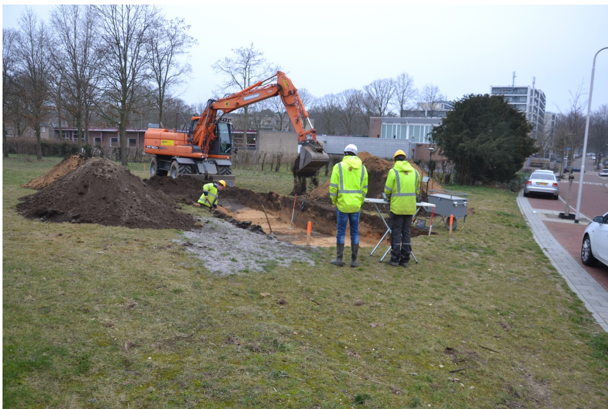
Figuur 4.1: De aanleg van de eerste werkput. BABN
