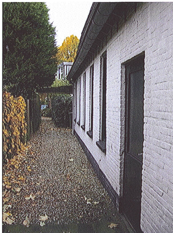
Fotonummer: 2 Omschrijving: Doorgang naar achterzijde perceel
