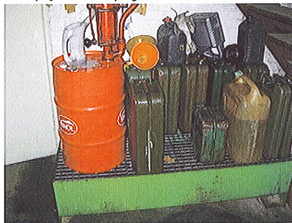
Fotonummer: 6 Omschrijving: Olieopslag met lekbak
