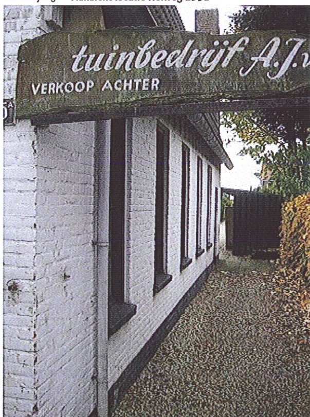
Fotonummer: 3 Omschrijving: Doorgang naar achterzijde perceel
