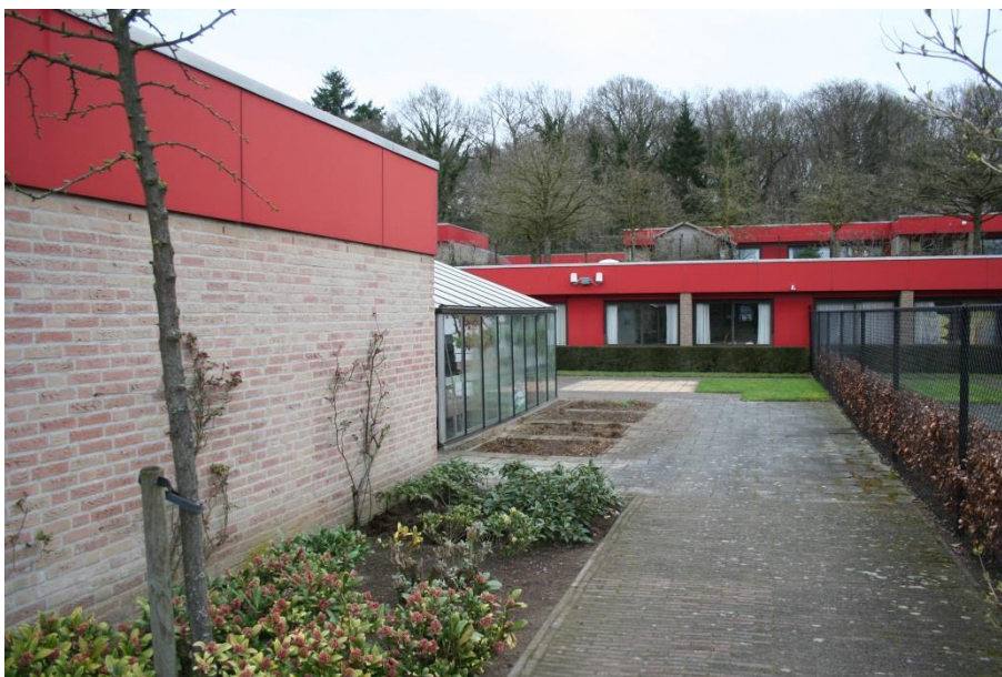
Plangebied richting stuwwal met terrasvormige bebouwing
