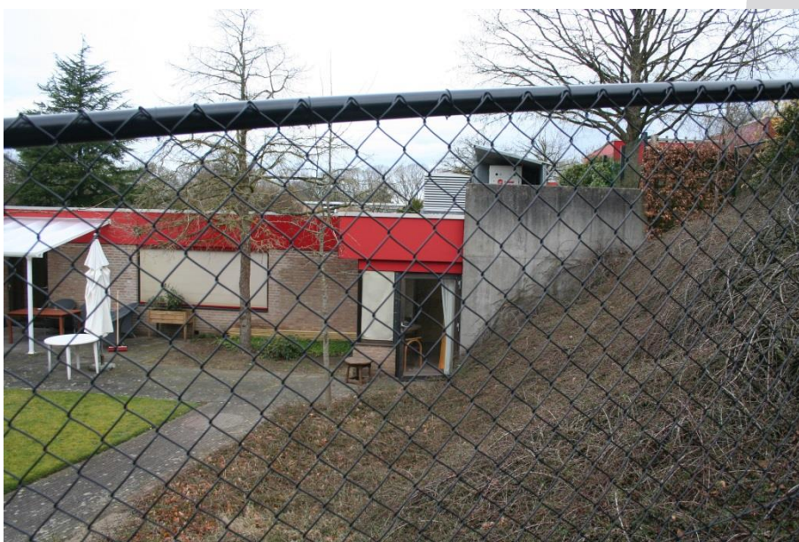
Keerwand ten behoeve van terrasvormige bebouwing
