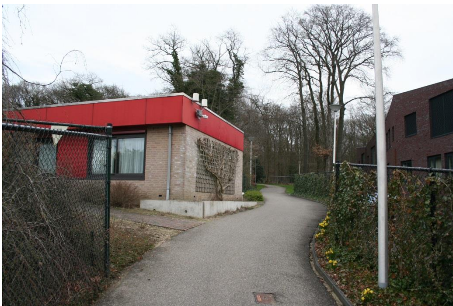
Pad langs zuidzijde van het plangebied omhoog richting stuwwal
