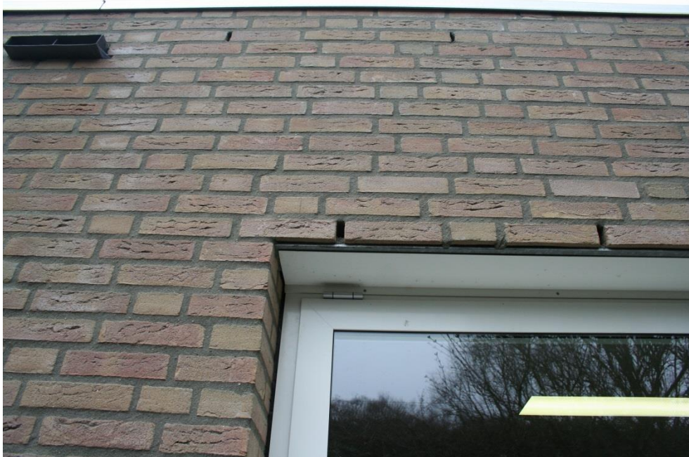
Detail muur deelgebied C
