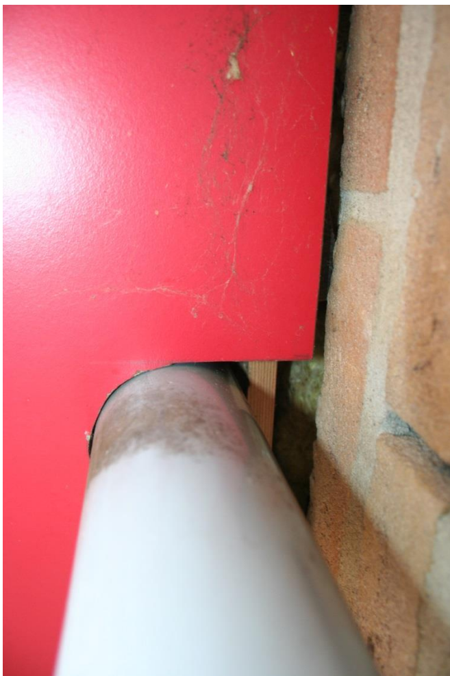
Doorvoer regenpijp deelgebied A
