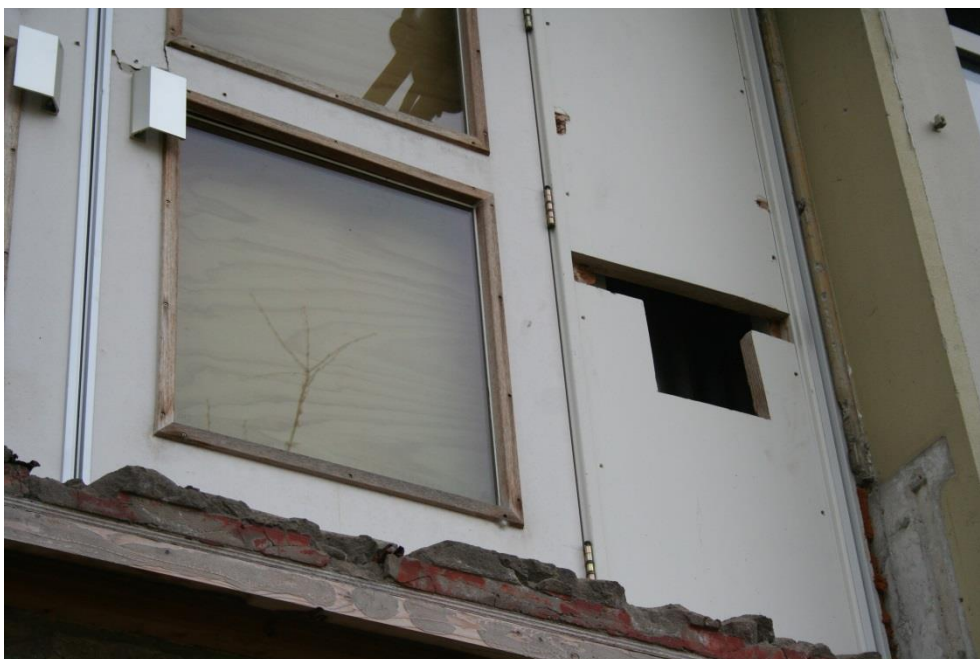
Noorzijde deelgebied B, vml. verbinding met aanbouw
