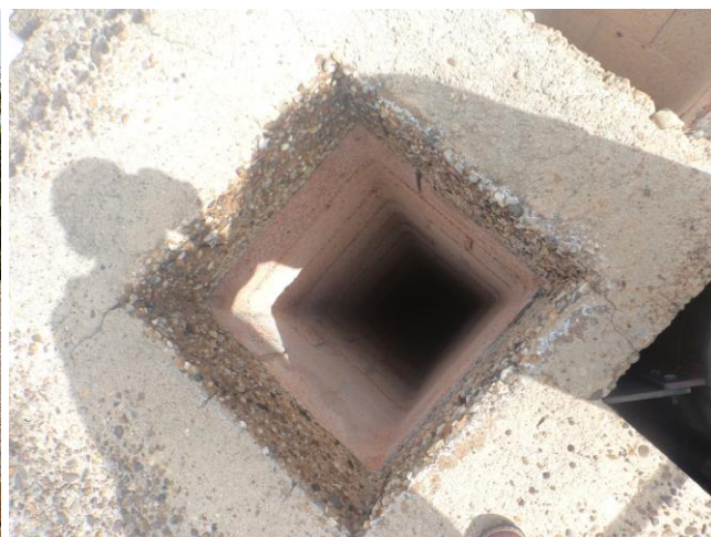
foto 6: schoorsteen stookruimte, metselwerk
