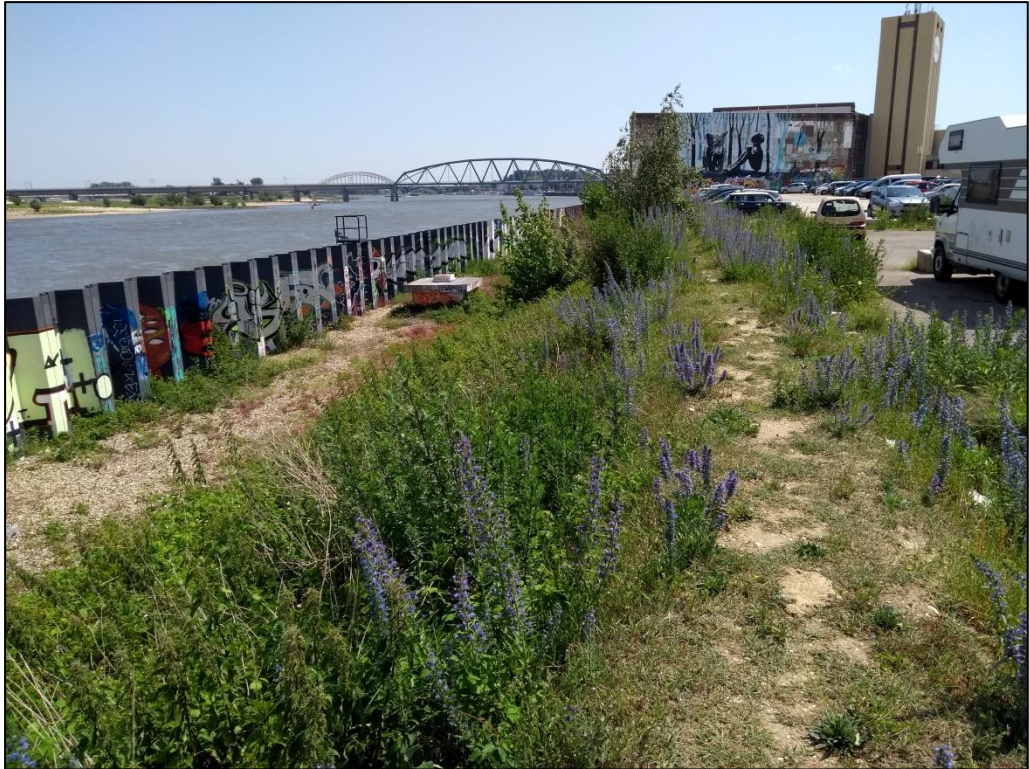
Het walletje en het talud kijkend naar het oosten, met rechts op de afbeelding het smalle paadje over het walletje en links de stalen damwand.
