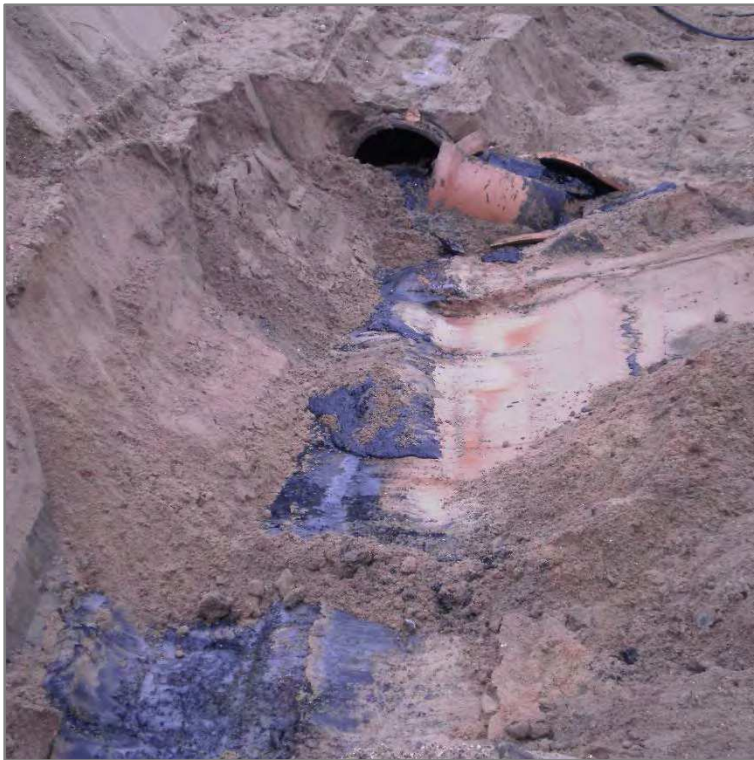
Figuur 11: Gresbuis en olieverontreiniging
