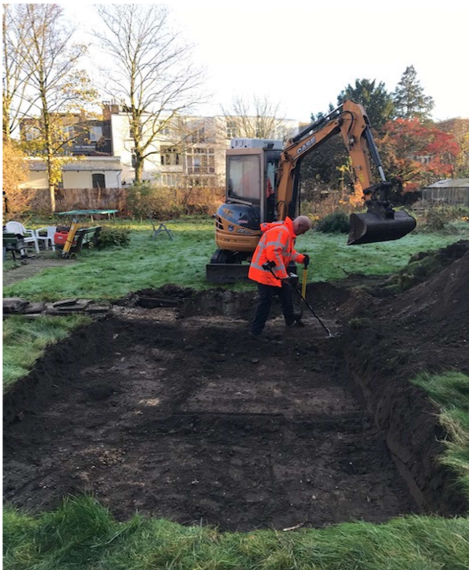
Figuur 3. OCE-werkzaamheden in het plangebied
