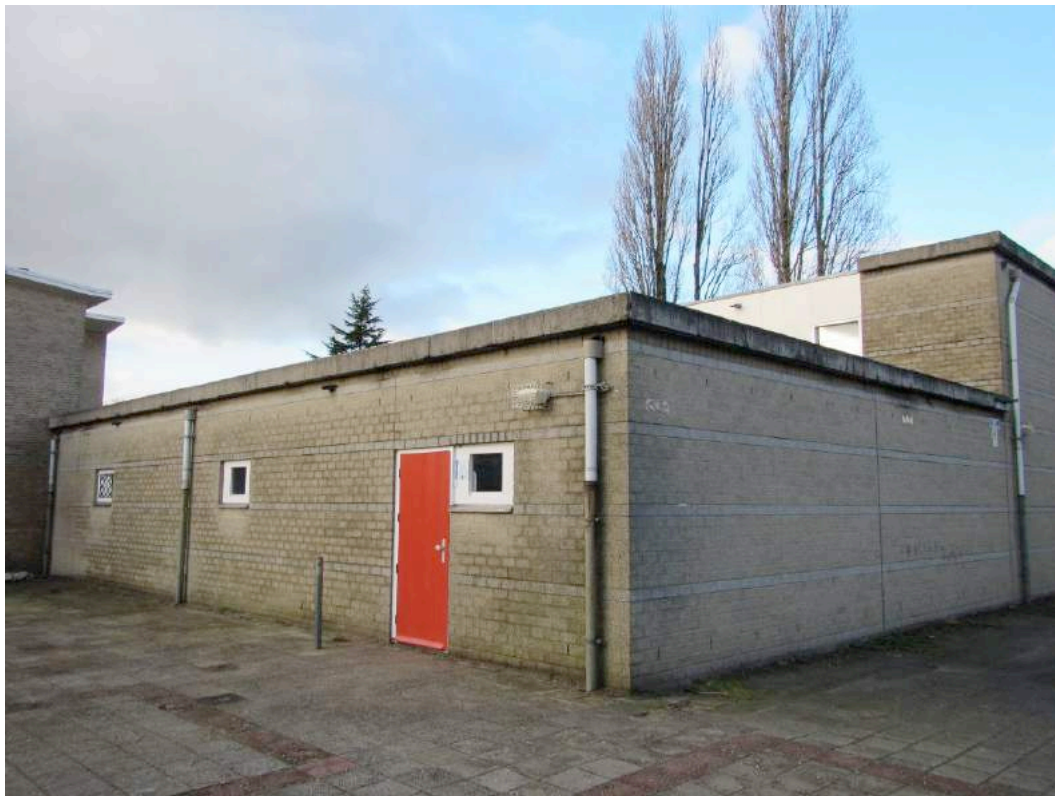
Figuur 4 Aangebouwde gymzaal.
