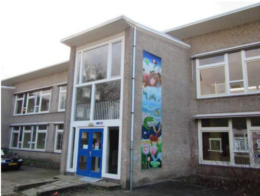
Figuur 2 Ingang van de school en trappenhuis aan de pleinzijde.
