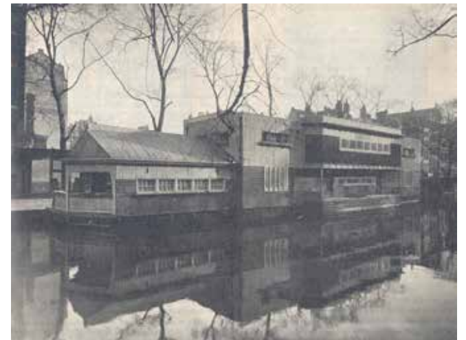
Afdeeling Gebouwen van den dienst der Publieke Werken Amsterdam; keet voor de bouw van een derde telefooncentrale te Amsterdam"*, architect A.H. van Wamelen
