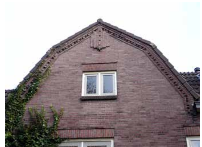
detailfoto kopgevel met siermetselwerk in topgevel en daklijsten
