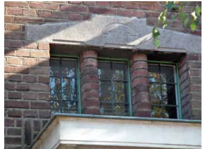
detailfoto raam boven voordeur
