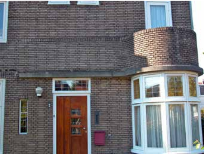
ronde uitbouw geïntegreerd met ontwerp van balkon en voortgezet in de geveluitbouw, uitbouw markeert hoek van de straat
