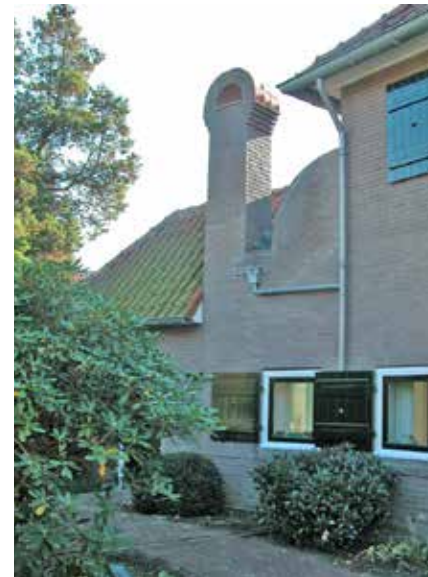
zijgevel van de Javastraat 41-67, architect A.H. Van Wamelen; expressieve schoorsteen die iets heeft van een keltische grafsteen
