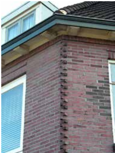
brede dakoverstekken met geprofileerde consoles; versterking van verticaal effect door siermetselwerk op de hoeken van de toren.
