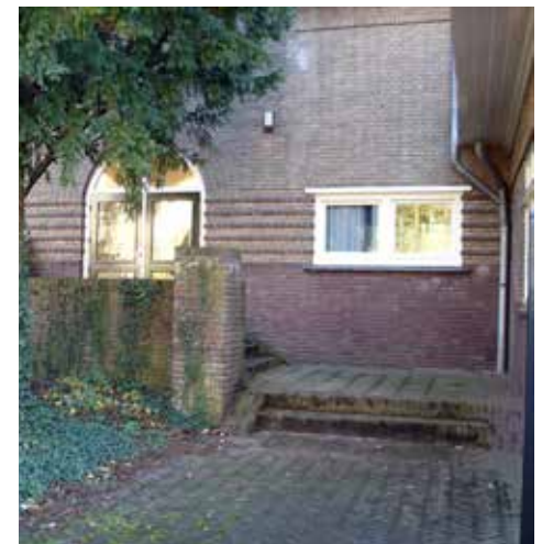
terugliggende entree in voorgevel, rooilijnsprong
