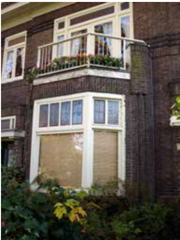
detailfoto uitbouw met balkon
