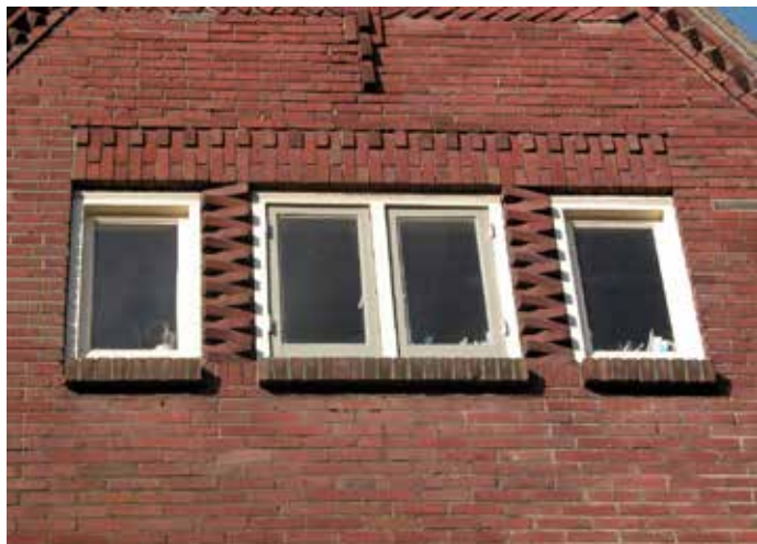
metselwerkdetails in fronton; siermetselwerk in rollaag en penanten
