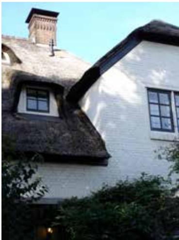
aansluiting riet op baksteen
