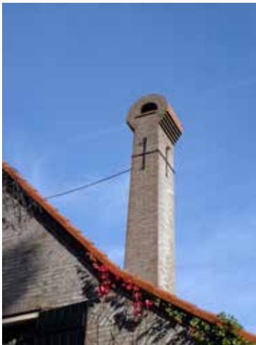
markante schoorsteen, metselwerkac- centen langs dakrand
