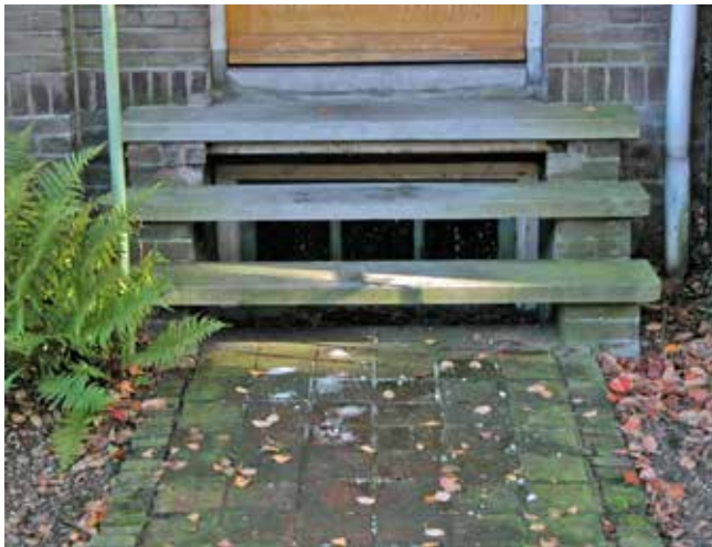
kelderraam onder trap bij voordeur
