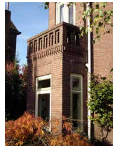
uitbouw met balkon en geprofileerde en gemetselde originele borstwering, architect Veugelaers
