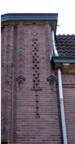
verticaal siermetselwerk, onderdeel van de achthoekige toren
