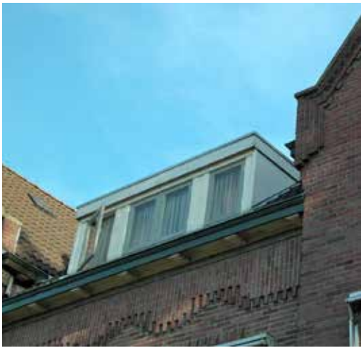
dakkapel; siermetselwerk in centraal deel van de gevel
