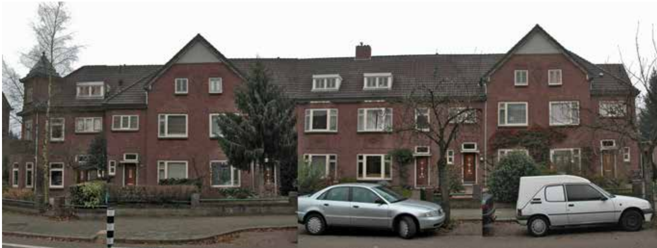
Javastraat 140-152, architect M.E. Veugelers
