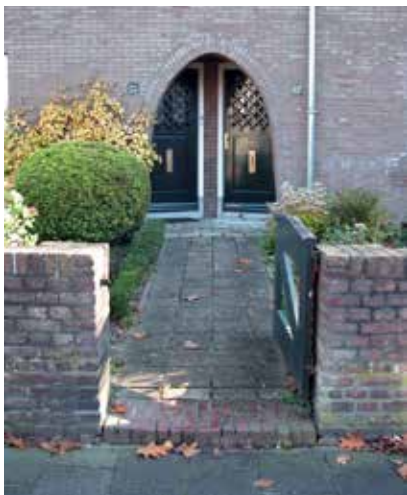
parabolische muuropening bij entree- portiek en gemetseld erfafscheiding
