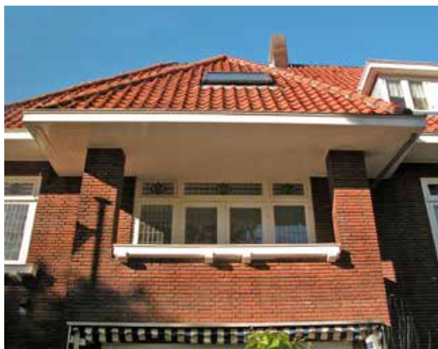
balkon opgenomen in kopgevel
