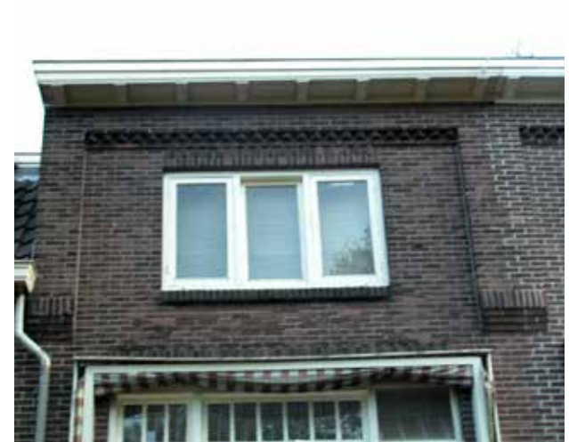
siermetselwerk in topgevel
