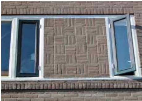
samenbinden kozijnen tot horizontaal element in de de gevel middels toepassing van kozijnvulling met decoratief metselwerk
