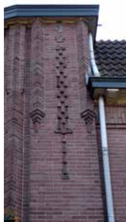
verticaal siermetselwerk, onderdeel van de achthoekige toren, architect Veugelaers
