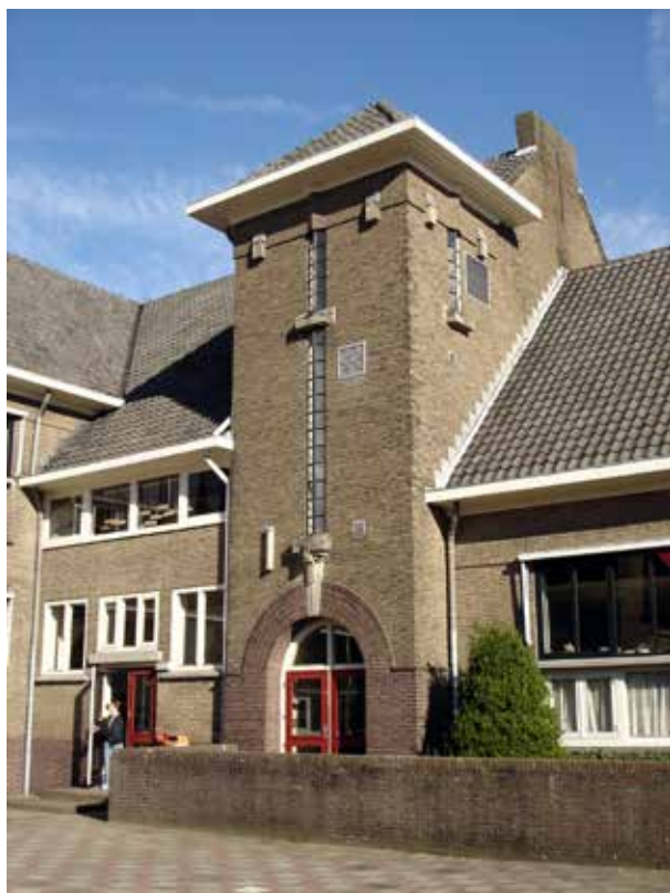
schoolgebouw aan de Timorstraat, gemeentelijk monument, markering entree aan achterzijde
