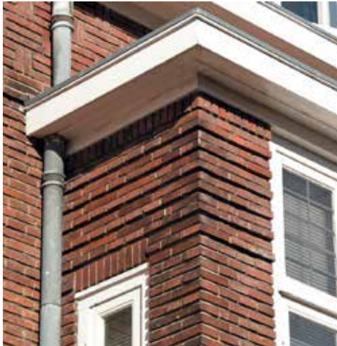
detailfoto hoek van uitbouw, ook hier siermetselwerk
