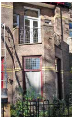
driehoekig gevormde uitbouw met balkon
