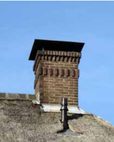
detailfoto metselwerk schoorsteen
