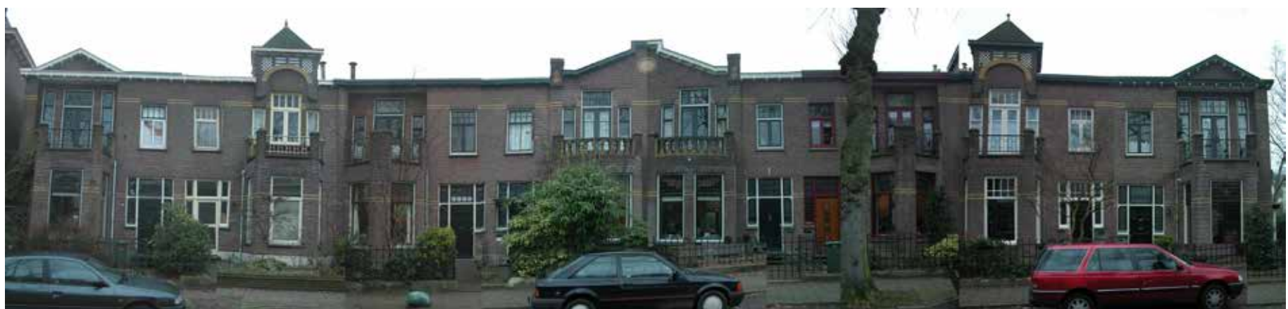
Sumatrastraat 6-20; architect P. Langhout
