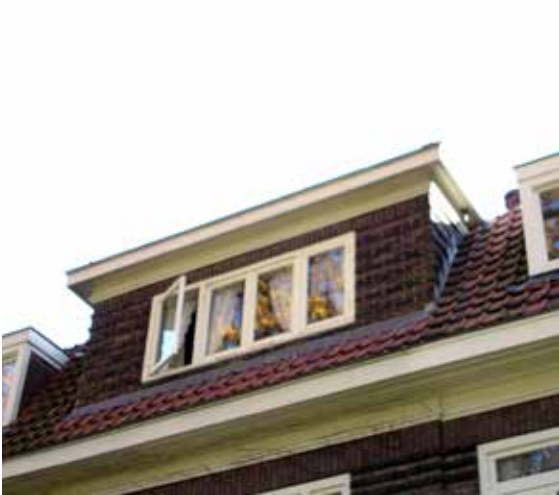
siermetselwerk t.p.v. dakkapel
