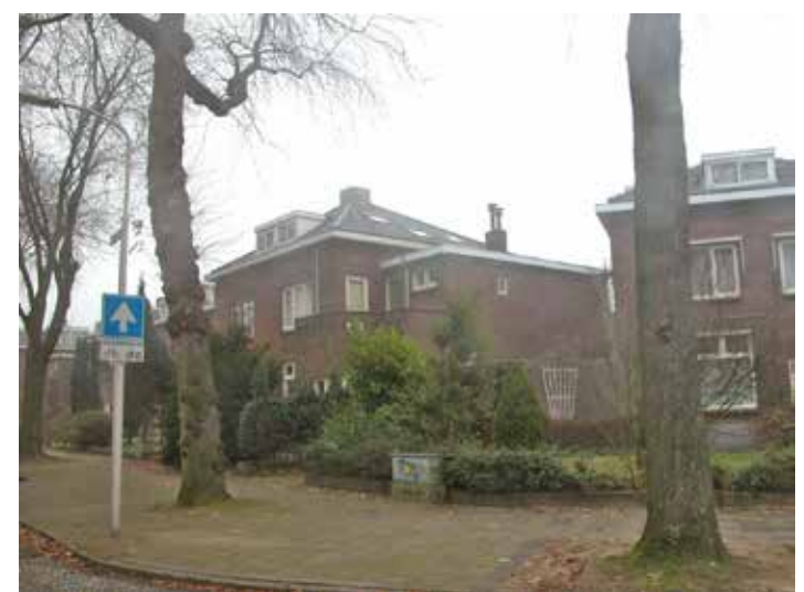
bouwblok Th. Arens, hoek Sumatrastraat - Sumatraplein
