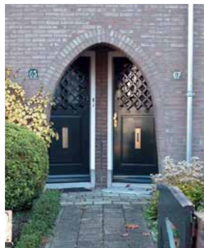
parabolische deurnis, architect Van Wamelen
