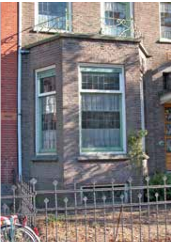
detailfoto uitbouw; ornamentaal balkonhekwerk
