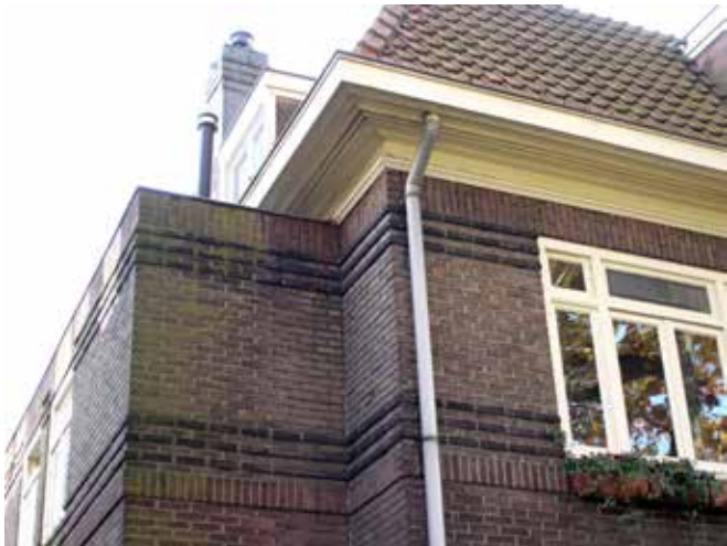
horizontaal siermetselwerk in gevel
