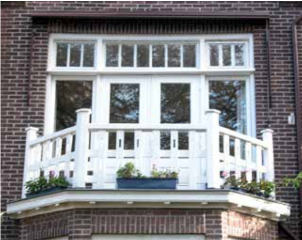
houten balkonhek en raampartij
