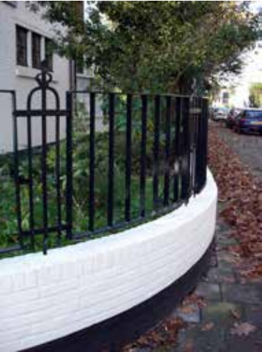
erfafscheiding: gemetselde muur met hekwerk
