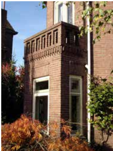
uitbouw met balkon en geprofileerde en gemetselde originele borstwering
