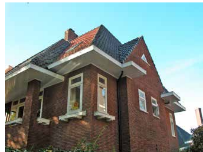
dynamiek van dakoverstekken in zijgevel
