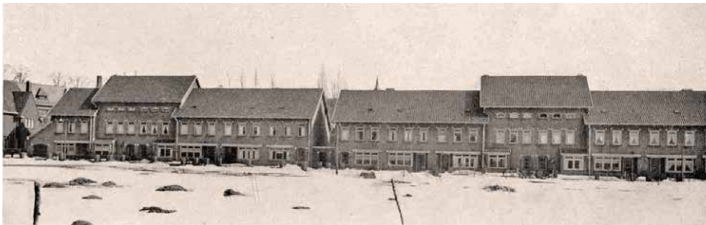
Fragment van de oostelijke straatgevel van de Delistraat door architect L.D. Kuipers, 1938. De door Meerman en Van der Pijll bekritiseerde betonnen lateien tekent zich duidelijk af in het gevelbeeld.
