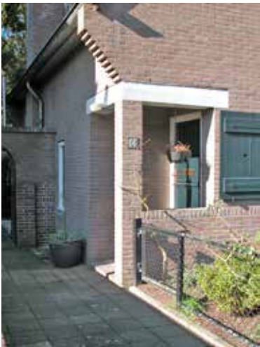
entree op de hoeken van de kopgevels
