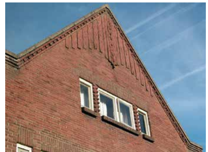
rijk gedetailleerd fronton; gemetselde ornamenten
