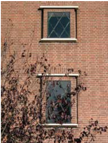
originele ramen in zijgevel
