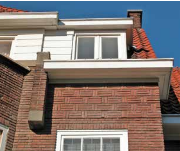
detailfoto hoek van type A1, siermetselwerk in gevel, dakkapellen zijn met hout afgewerkt
