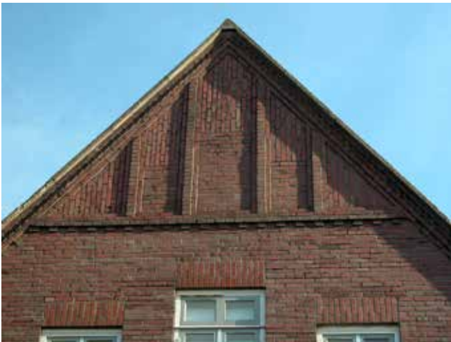
details in metselwerk in fronton zorgen voor een versterking van de verticaliteit
