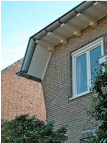
nr. 5-7; bouwblokafsluiting, dakoverstek, geprofileerde consoles
