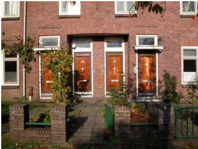
deurensemble (originele deuren)
