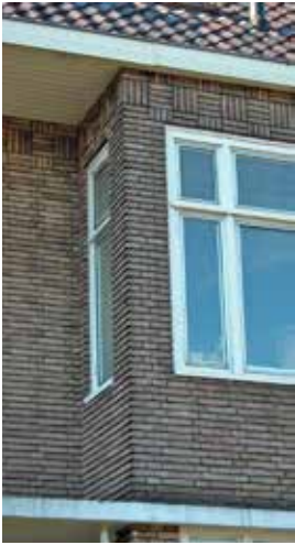
accenten in metselwerk en zijraam t.p.v. in rooilijn verspringend geveldeel
