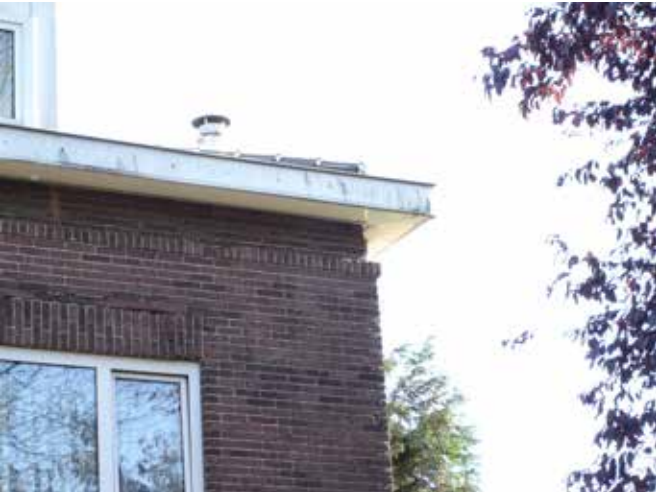
siermetselwerk, rollaag en dakoverstek
