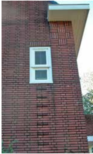
nr. 1-3; siermetselwerk in gevel
