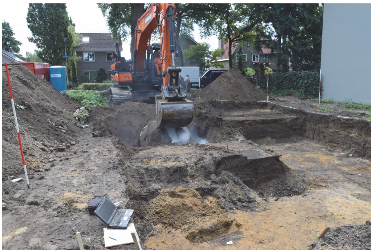
Figuur 4.1. De betonnen septic tank wordt verwijderd. Foto genomen richting het oosten. FH
