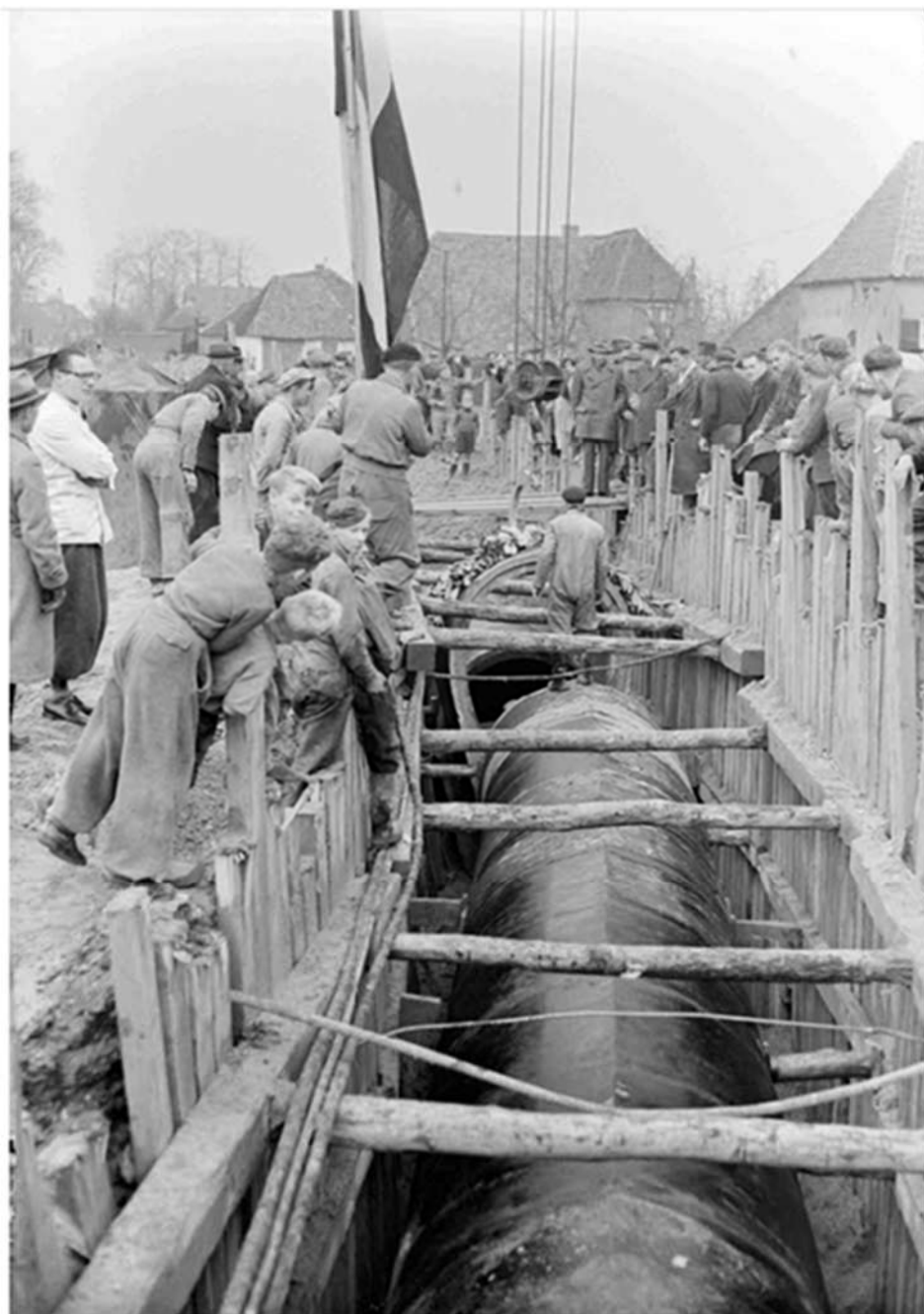
Figuur 3.2: Het handmatig uitgraven van een riooltracé in de Schependomlaan te Nijmegen door middel van een houten bekisting (bron: Regionaal Archief Nijmegen, fotonummer onbekend, jaartal 1952).
