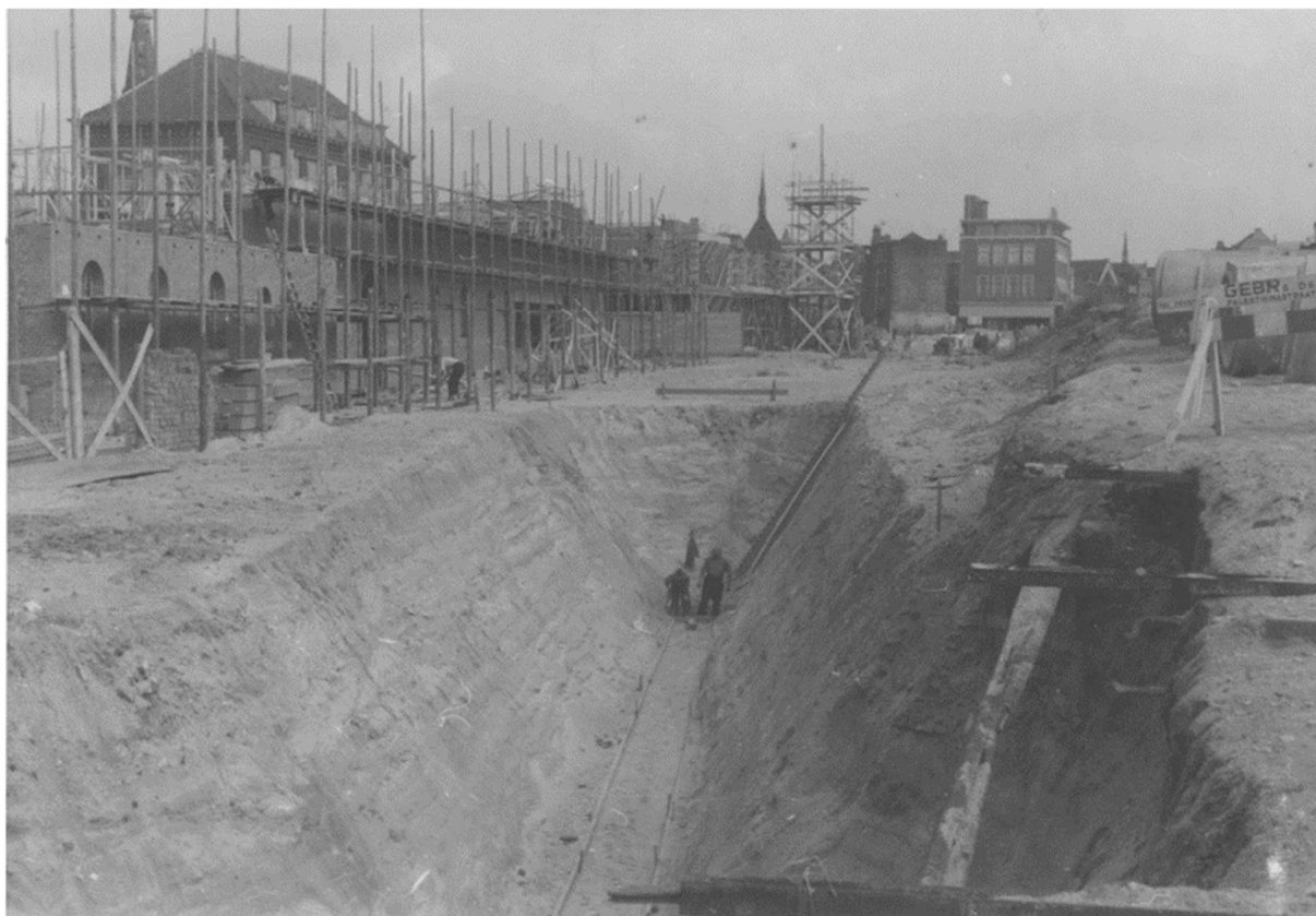
Figuur 3.3: Het uitgraven van een riooltracé in Doddendaal door middel van een dragline of sleepgraver (bron: Regionaal Archief Nijmegen, F16177, jaartal 1950).
