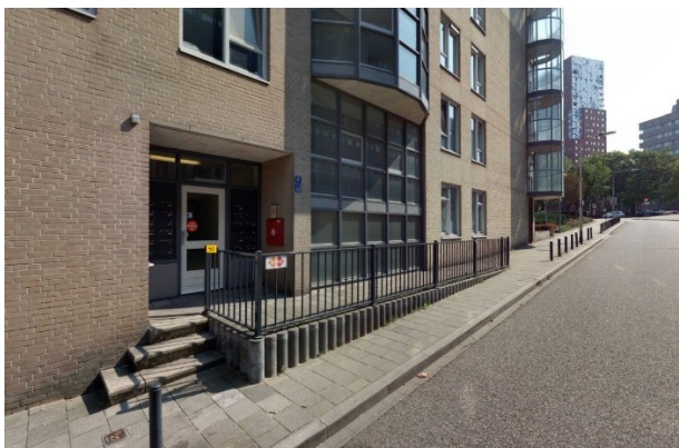
Figuur 3: Vernauwing in trottoir nabij appartement
