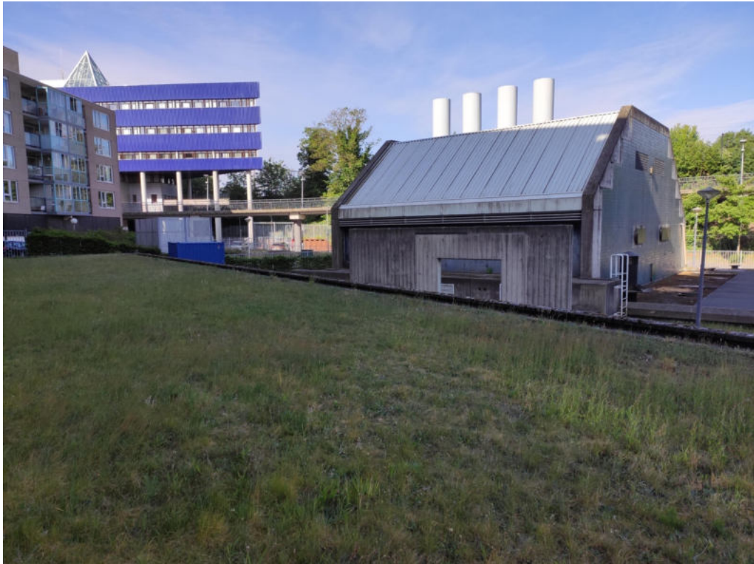
Figuur 6 Achterzijde pompstation met grasveld op verhoging, waaronder zich een kelder bevindt.
