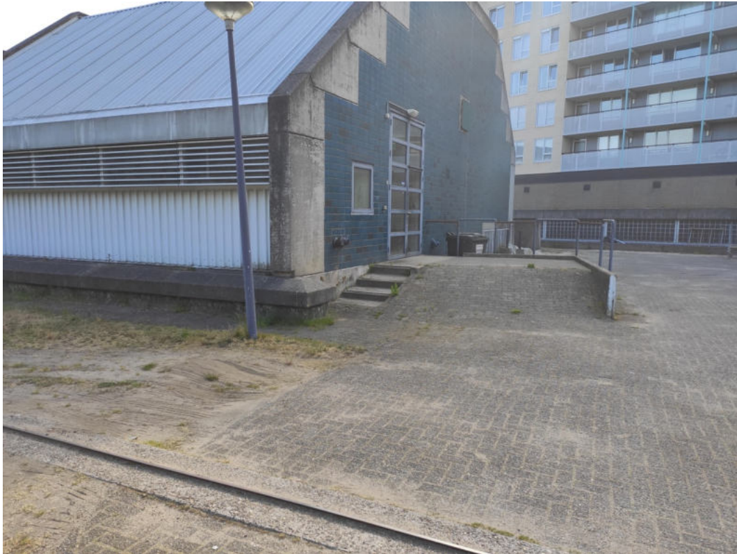
Figuur 2 Voorzijde van perceel 52 met het pompstation.
