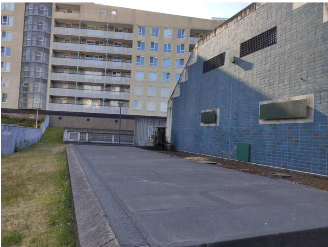
Figuur 5 Zijkant van het pompstation met kelder waarin enkele watertanks gevestigd zijn.
