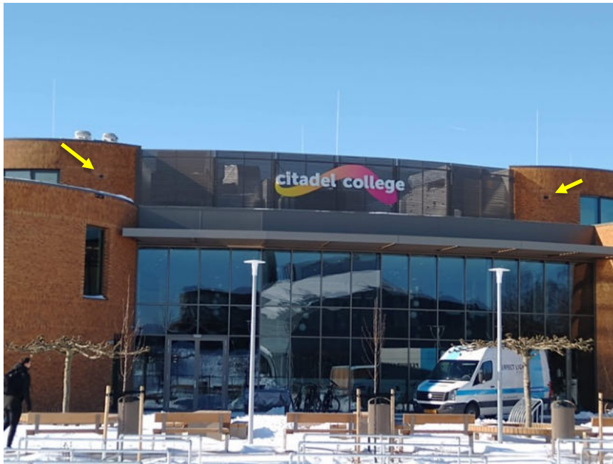
De 2 inbouwkasten in de nieuwbouw van het Citadel college (oostzijde gebouw).
