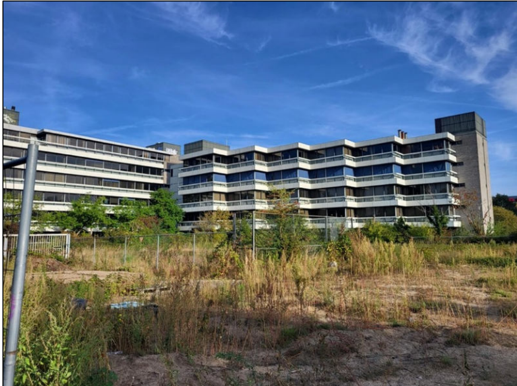
Figuur 1.1 Oude UWV-gebouw met braakliggend terrein rondom het gebouw.
