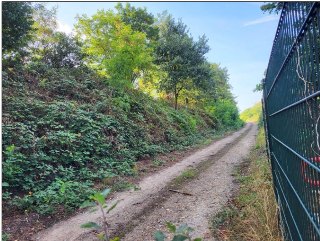
Figuur 5 Weg over het spoortalud aan de oostzijde van het plangebied.
