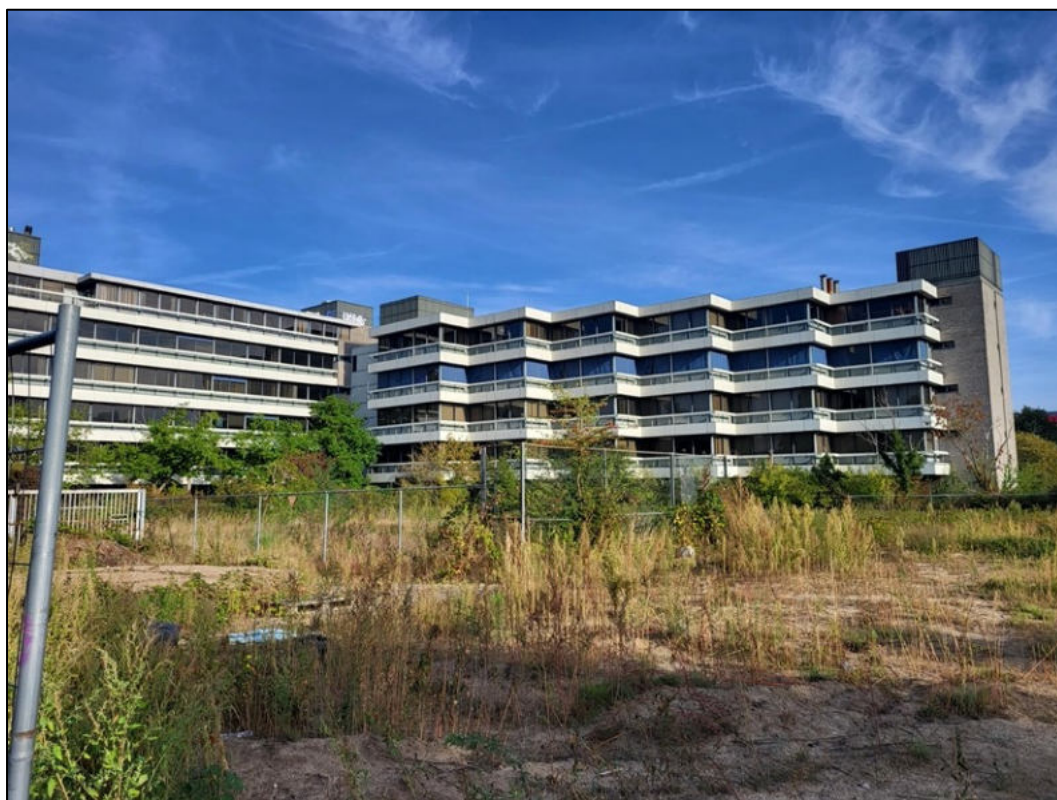
Figuur 2 Zuidoostzijde van de bebouwing met de voormalige parkeerplaats met ruigte.
