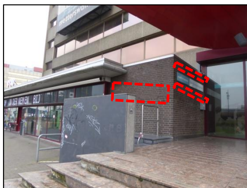
Boven: open stootvoegen aan de noordzijde van het gebouw. Onder open stootvoegen aan de westzijde van het gebouw. De locaties van de open stootvoegen zijn rood gearceerd.
