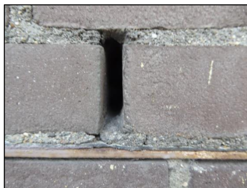
Boven: open stootvoegen aan de noordzijde van het gebouw. Onder open stootvoegen aan de westzijde van het gebouw. De locaties van de open stootvoegen zijn rood gearceerd.
