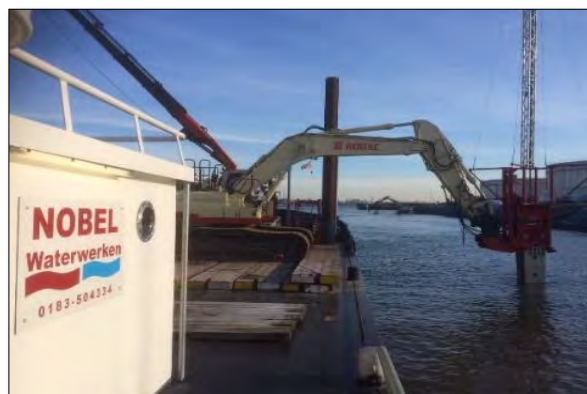
Uitvoeren dieptedetectie t.p.v. de waterbodem
