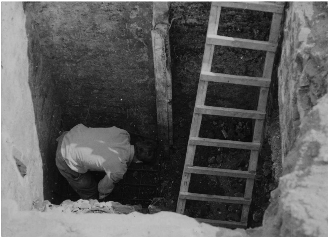
Figuur 14. Wapening voor een poer wordt geplaatst tussen bestaand muurwerk (bron: Regionaal Archief Nijmegen, Jeroen de Groot).
