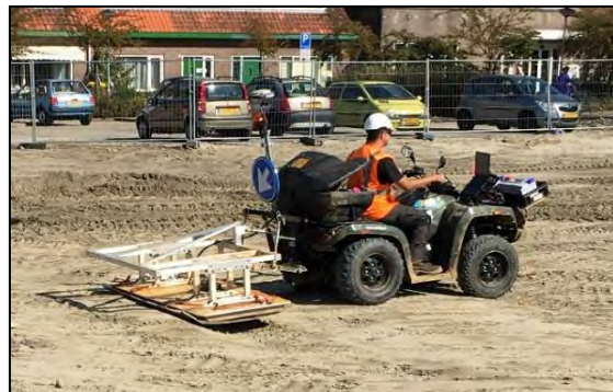
De 3D grondradar achter een quad
