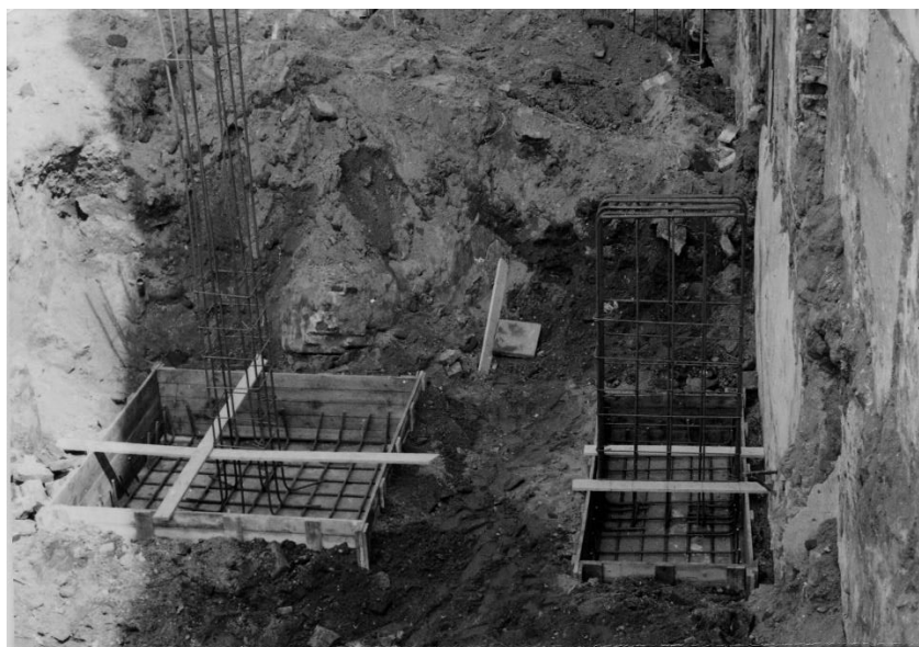
Figuur 13. Ontgraving voor de aanleg van enkele poeren (bron: Regionaal Archief Nijmegen, Jeroen de Groot).
