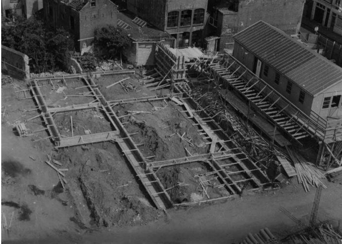
Figuur 16. Overzichtsfoto van de aanleg van de fundering van de Molenpoortpassage. De ruimte tussen de funderingssleuven lijkt niet diep te zijn verstoord. (bron: Regionaal Archief Nijmegen, Jeroen de Groot).
