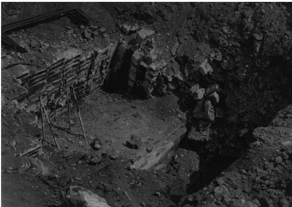
Figuur 15. Bakstenen funderingen in het plangebied ten tijde van de bouwwerkzaamheden (bron: Regionaal archief Nijmegen, Jeroen de Groot)..
