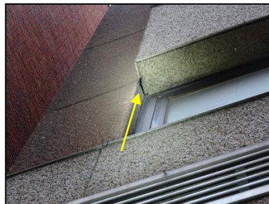
Figuur 10. Geschikte nestlocatie voor gierzwaluw en huismus via opening in wandafwerking.
