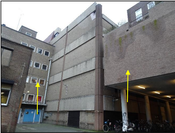
Figuur 15. Aangrenzende bebouwing zuidwestzijde van onderzoekslocatie.
