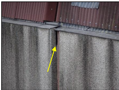
Figuur 9. Geschikte nestlocatie voor gierzwaluw en huismus via opening in wandafwerking.
