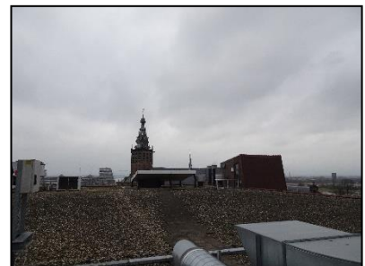
Figuur 8. Bovenste dak van de onderzoekslocatie (foto genomen richting het noordoosten).
