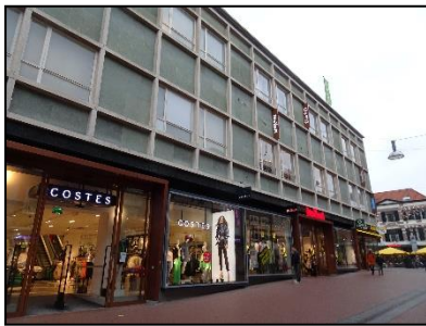
Figuur 3. Oostzijde onderzoekslocatie (Broerstraat).
