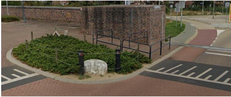
Figuur 18: Maatregel bij een blinde muur om ervoor te zorgen dat voetgangers vlak daarachter opduiken, maar al eerder zichtbaar zijn voor het aankomend verkeer doordat ze er 'omheen' begeleid worden (voorbeeld Bergstraat, Herten)
