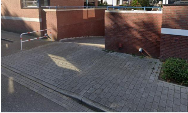
Figuur 16: Maatregel bij uitgang parkeergarage (hekje ene zijde, groenvak andere zijde) (voorbeeld Roerhaven, Roermond)
