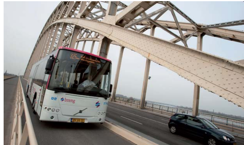
HOV-verbinding over de Waalbrug
