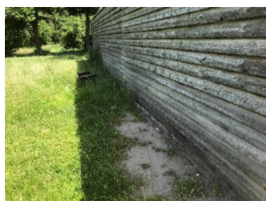
foto 11 - klinkerverharding (begroeid met gras) ter plaatse van de druppelzone
