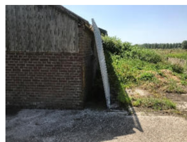
foto 12 - betonverharding ter plaatse van de druppelzone
