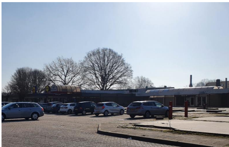
Afb. 20 Winkelcentrum, gezien vanuit het noordwesten met parkeerterrein op de voorgrond. Rechtsvoor de fundering van het afgebrande volume.
