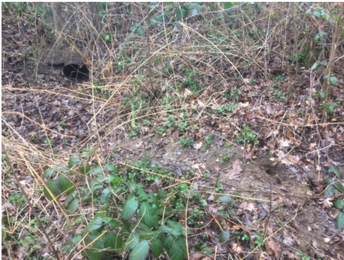
Figuur 4. Faunatunnels onder het viaduct Staddijk en de toegangsweg van het plangebied zorgen er voor dat de das zich vrij kan bewegen tussen verblijfplaatsen en foerageergebied.
