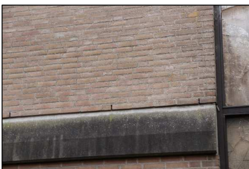
Foto 3 Spouwmuur in schoolgebouw
