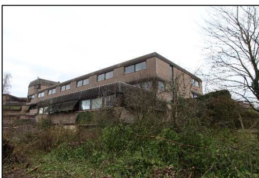
Foto 4 Noordzijde van schoolgebouw
