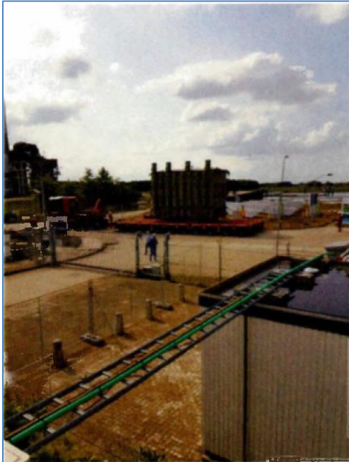
Figuur 11: Transport machinetrafo, nov. 2019
