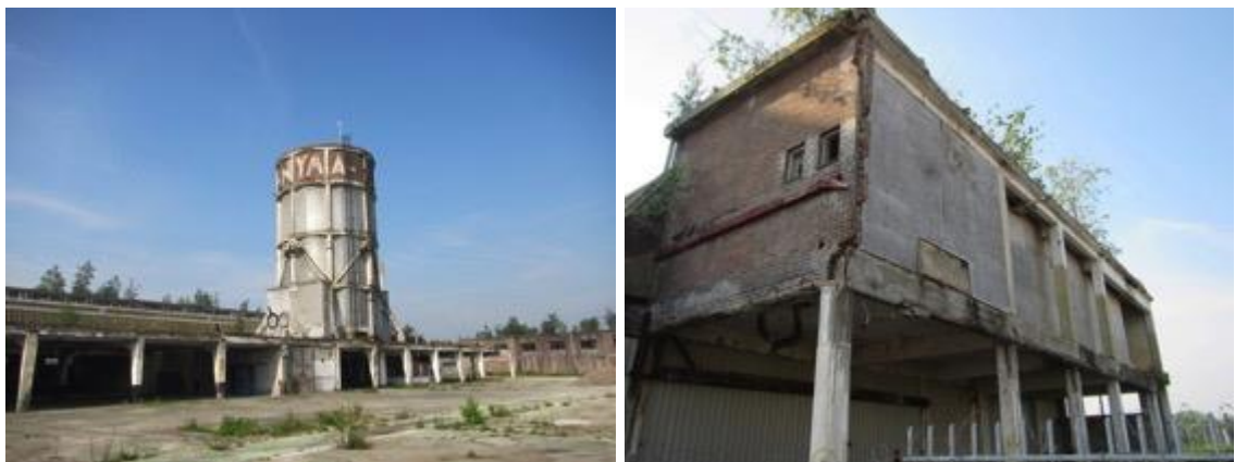
Figuur 2 Industriële watertoren op het NYMA terrein aan de noordzijde van de fabriek (links) en het hoofdgebouw bij het toegangshek (rechts).
