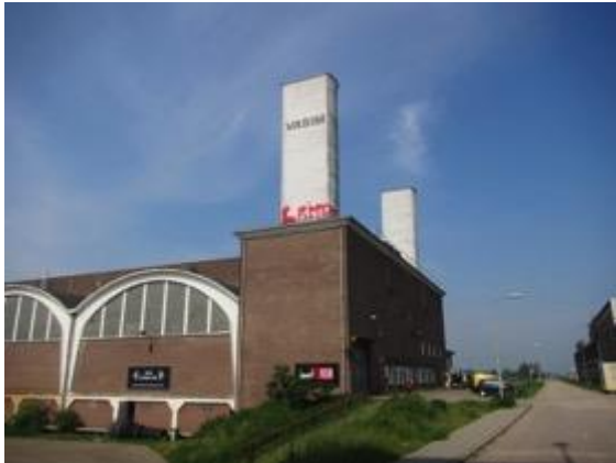
Figuur 9 Oost- en noordgevel van het Vasim gebouw met rechts de Winselingseweg.
