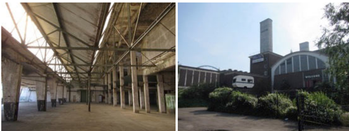
Figuur 6 Open fabriekshal op het NYMA terrein (links) en westgevel van de fabriekshal van Vasim (rechts).
