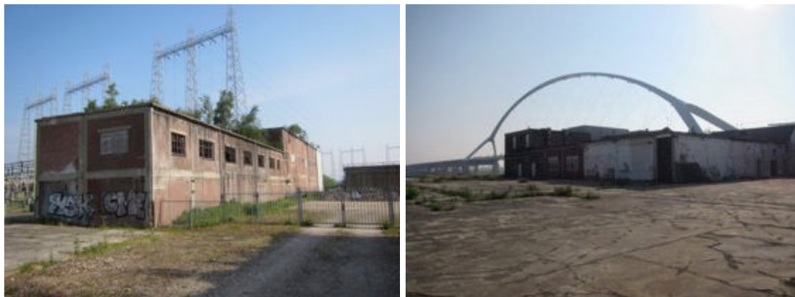
Figuur 3 Bijgebouw ten westen van de toegangsweg op het NYMA terrein (links) en de fabriek met kantoor langs de rivier de Waal (rechts).
