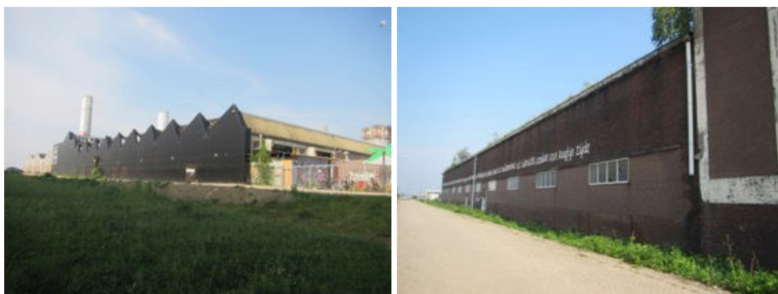
Figuur 5 Oostgevel van de voormalige fabriekshal NYMA (links) en fabrieksgevel van NYMA langs de Winselingsweg (rechts).
