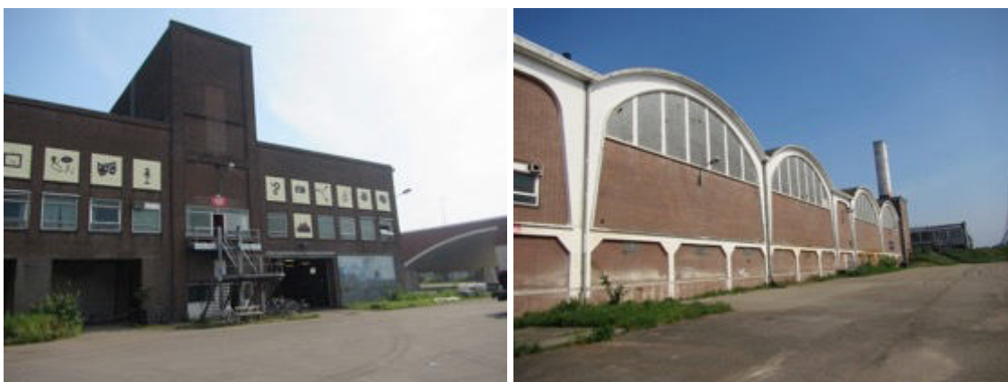
Figuur 8 Zuidgevel van het Vasim gebouw (links) en de oostgevel van het Vasim gebouw met een grote geasfalteerde parkeerplaats (rechts).
