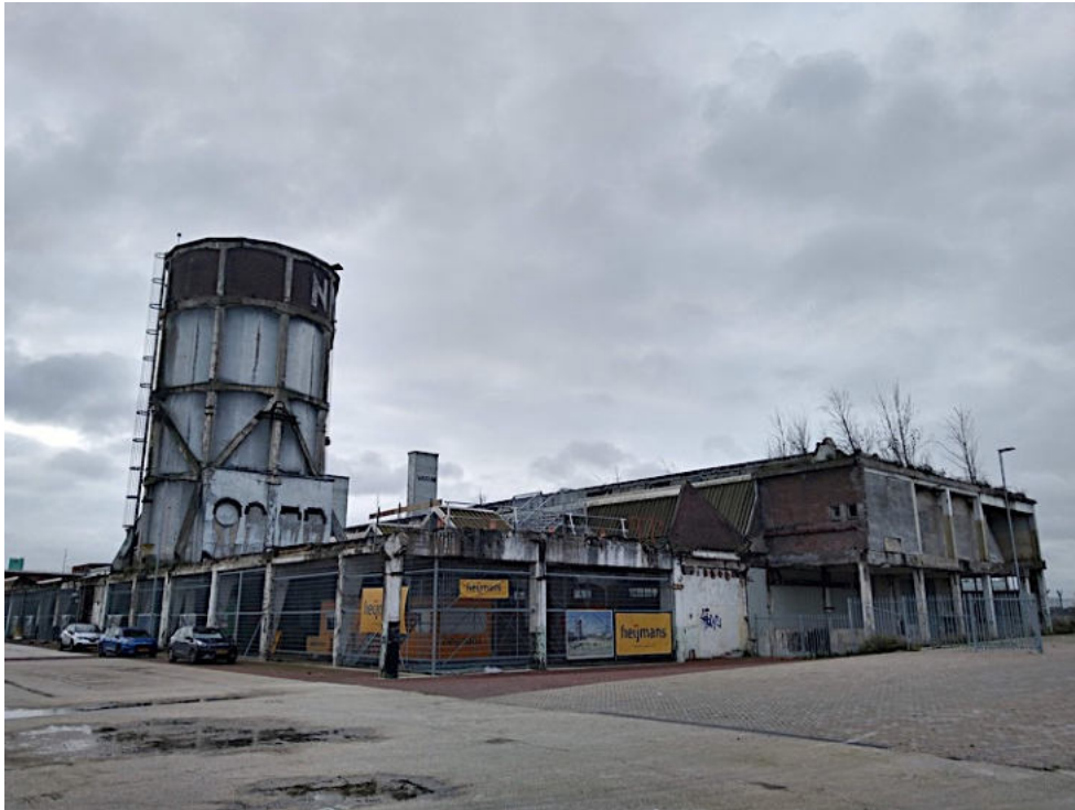
Figuur 3.2 Foto van het NYMA-terrein in november 2020 met de industriële watertoren. Het terrein is grotendeels verhard. Op het fabrieksgebouw groeien jonge berken. Onderdeel van de ingreep is renovatie van dit pand en de toren.
