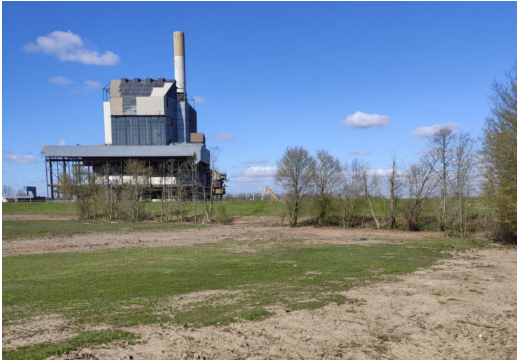
Foto 1 Overzicht van plangebied vanaf de oostelijke hoek.
