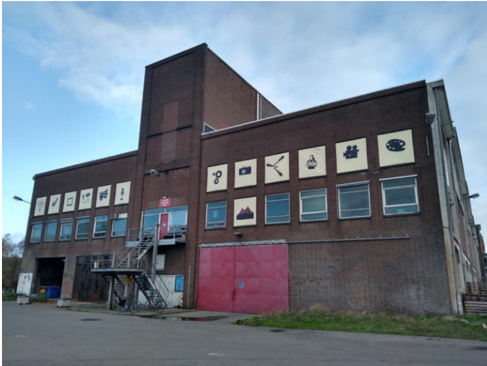
Figuur 3.2 Foto van het Vasim-terrein in november 2020. Aan de randen van de voormalige fabriekshal staat opslag van ruigte, struiken en bomen. Het terrein is grotendeels verhard. Het gebouw wordt o.a. door kunstenaars gebruikt als werkplaats.
